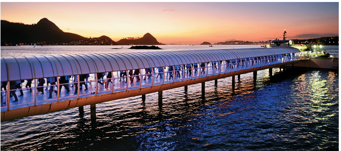
Estação Hidroviária de Charitas. Local de transbordo para Catamarã. A viagem para o centro do Rio de Janeiro dura em torno de 20 minutos (CCR-BARCAS, 2022).
